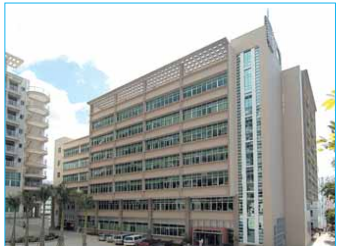
Das neue Gebäude – auf sieben Etagen Platz für 3.000 Techniker
